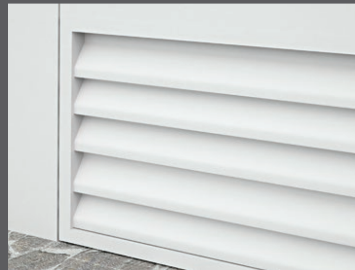
Dettaglio ventilazione con lamelle Slat-shaped ventilation detail
